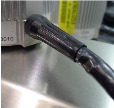
Figura 5: Cavo danneggiato nel punto del dispositivo anti piega del motore
