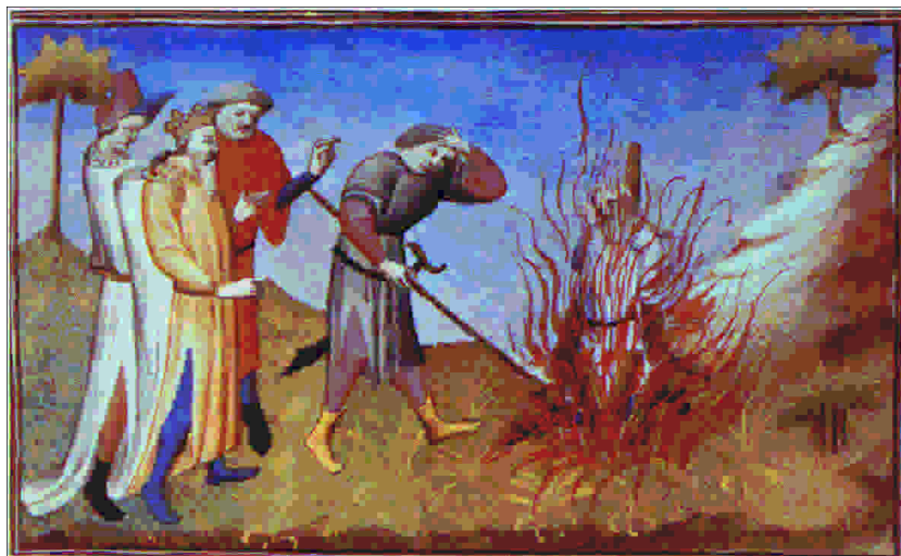
I grattacapi del boia: il condannato vestito con amianto non prende fuoco (stampa francese del XIV secolo in cui si riferisce del viaggio di Marco Polo in Cina Bibliothèque Nationale, Paris)
